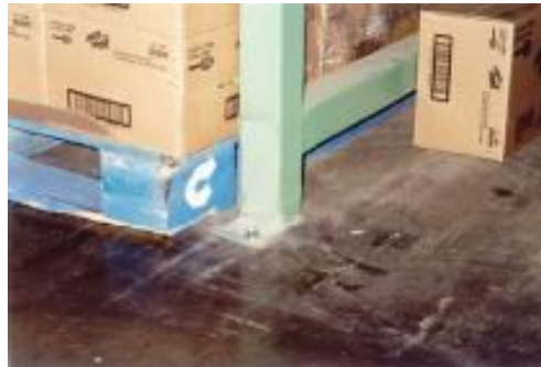
Figura 10. Aplicación de carga en postes de racks. Fuente: foto de la bodega (propia)
