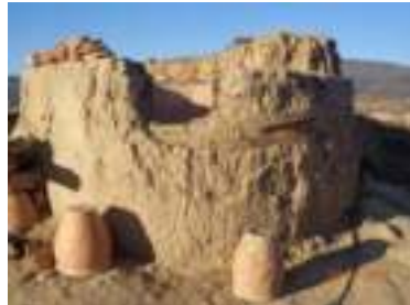
Exterior del horno
