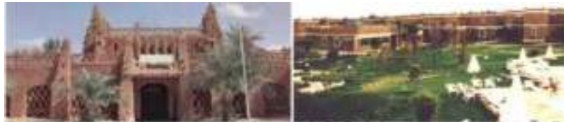
Fig. 32 a) Fachada del centro Artesanal Regional de El Rachidia en Marruecos, del Arqto. Francés Jean Paul Ichter. 1979. b) Hotel del Ouzú Rojo, edificado en el centro de la nueva ciudad de Timimoun, Sahara, Argelia. 1930. c) Hotel Salt LicK Game Lodge. Kenia. d) Hotel residencial. Realizado en BTC por Altech Internacional 1995.
