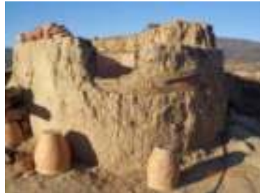
Exterior del horno
