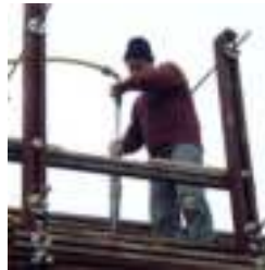
vibrando el material
