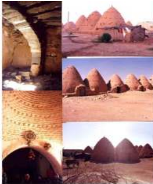
Fig 1 Estructura en cúpula abierta en construcciones tradicionales. Excavaciones arqueológicas en Tell Beyrút dentro del Eneolítico. Se venían muebles en estructuras curvadas, edificadas en zonas de 30 y construyeron de 75 casas de granos, con adobe de 13x50x10 cm. Incluye la sala, y cubiertas situas de las de las con volúmenes de cúpulas
