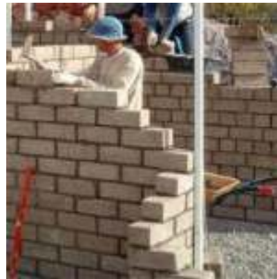
Puesta en obra del BTC
