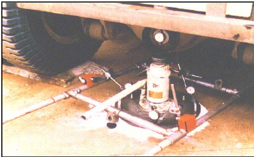
Fig. 2.1. Ensayo placa de carga
