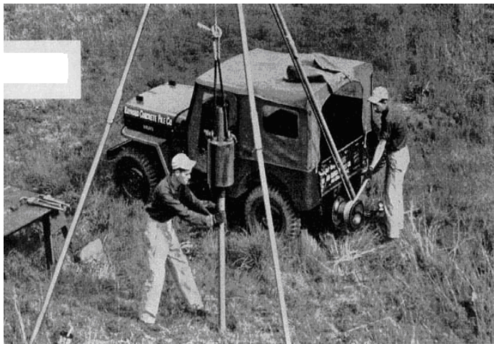
Fig. 2.2. Ensayo de Penetración Estándar
