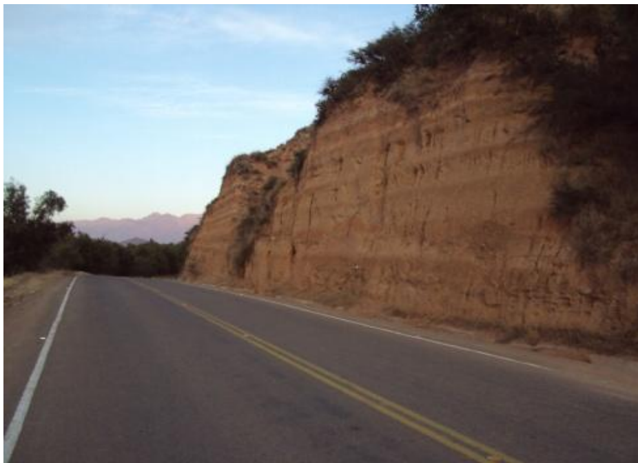
Foto 3.4 Talud N° 2 progresiva 1+1600
