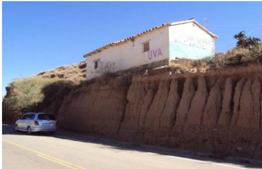
Foto 3.3 Talud N° 1 progresiva 0+600
