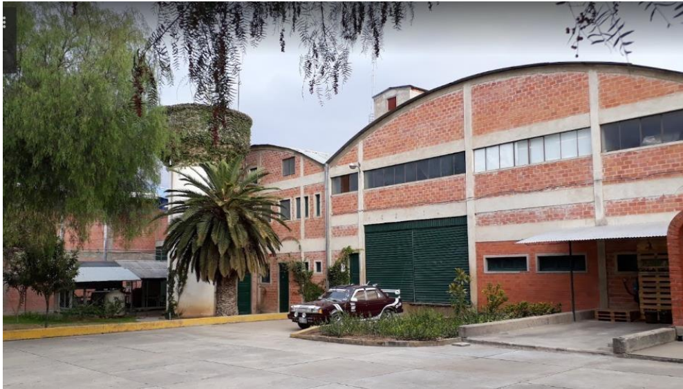
Ilustración 4 Bodegas Casa Real
