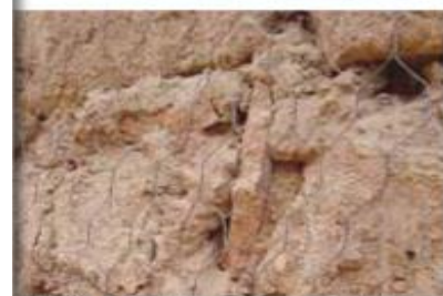
Utilización de tejas rotas o malla para mejor adhesión
