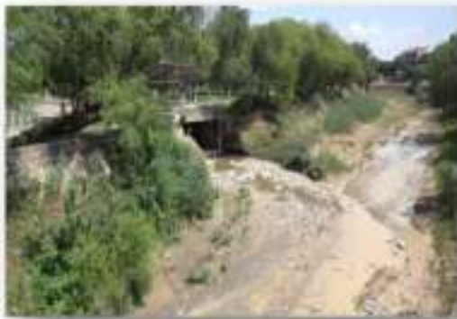
QUEBRADA EL MONTE SOBRE CALLE TORREJON
