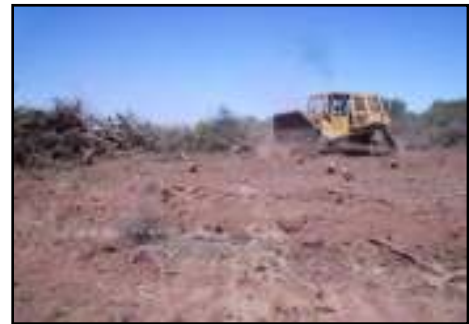
Degradación por asentamientos
