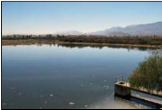
LAGUNAS DE OXIDACIÓN
