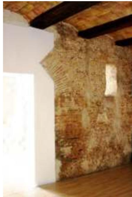
Se han recuperado los muros originales de tapial reforzados con verdugadas de ladrillo, eliminado los revestimientos que tenían. Los muros que estaban peor o tenían menos interés se han revestido de placas de pladur, y por detrás de estos pasan todas las instalaciones necesarias para el adecuado funcionamiento del edificio, instalación eléctrica de aire acondicionado y fontanería.
