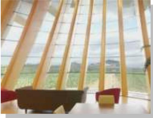
vigas de madera laminada, que apoyan sobre los muros laterales, colocadas sobre planos inclinados y en sentido transversal al eje longitudinal del edificio. Así, su envolvente exterior crea una superficie reglada combinando superficies cóncavas y convexas.
