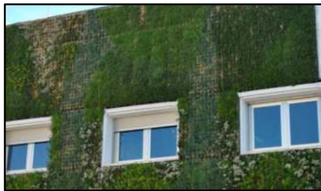
Figura 60 Fuente: muro tipo gavión – web
