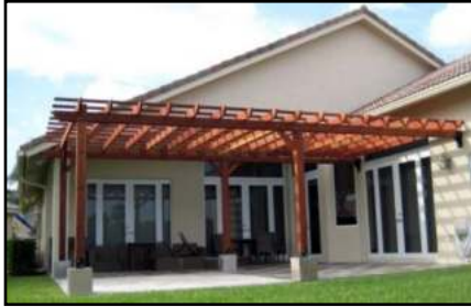
Figura 43 Fuente: pérgolas - web
