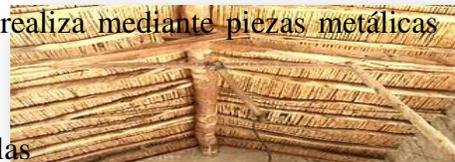
Las estructuras que se pueden ver varían de las construcciones más simples (viga central, sistema secundario que soporta la capa de cañas) hasta las más complejas, que cuentan con llaves en las vigas transversales aparentes y una estructura en forma de cruz que aguanta el caballete. Están consolidadas en muchos casos mediante un tirante horizontal.
