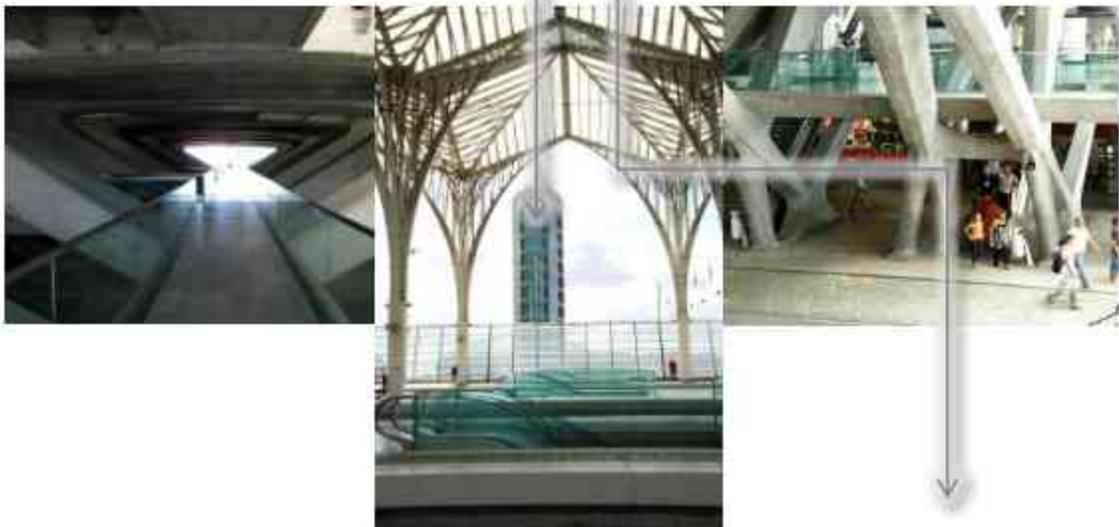
Las vías se distribuyen en torno a 4 andenes, sobre los que descansa una gran estructura metálica donde éstos se encuentran coronadas por una cantidad de 60 árboles de acero y cubiertas onduladas de cristal de 25 metros de altura y cerca de 40
