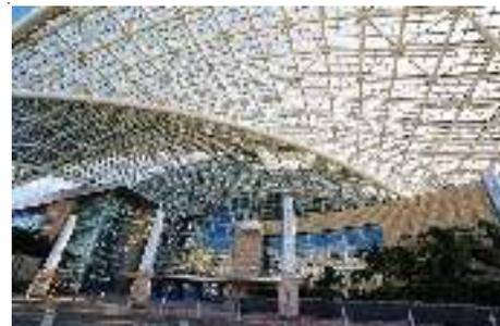
En la proporción de materiales empleados para la construcción se puede percibir los materiales propios de la región en los revestimientos tenemos la piedra, madera, ladrillo tradicional, en cuanto a la apertura de ventanas y recorridos tenemos el vidrio permitiendo total transparencia e integración del ambiente natural. Para cubrir espacios semiabiertos se tiene perfiles metálicos en elementos como cerchas que se pueden apreciar a la vista.
