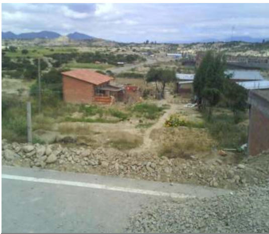
Vivienda de adobe
