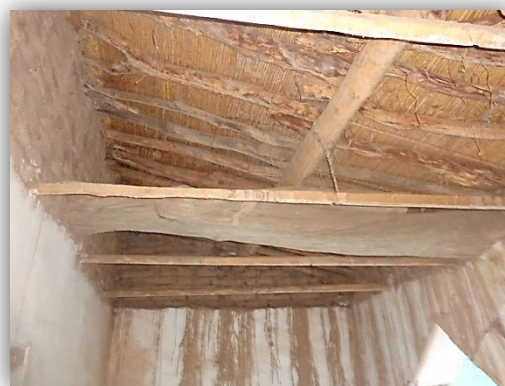
Cubierta de madera
