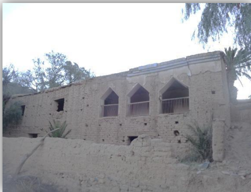
Fachada de bodega y galería
