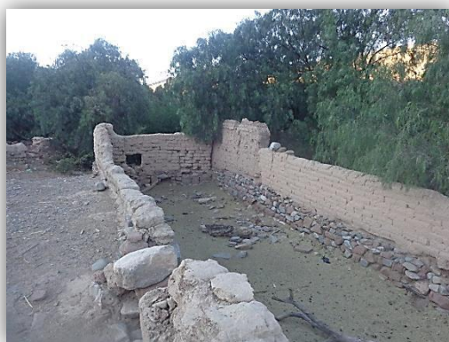
Cimiento de piedra
