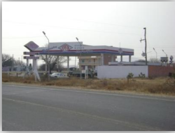
Estación de Servicios graneros
