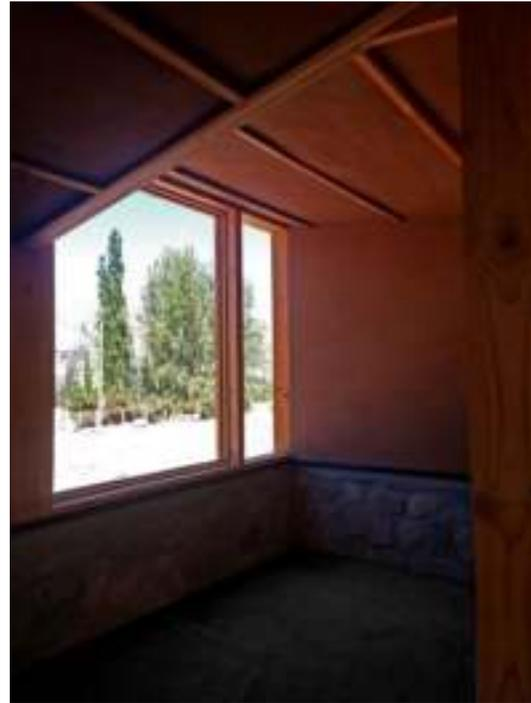
tanto en los muros perimetrales como en la cubierta; aprovechando la inercia térmica de los materiales en conjunción con la orientación solar de los vanos y la dirección del viento como estrategias de diseño pasivo. Los recintos comunes se abren hacia el valle, enmarcando las vistas con un gran ventanal y una vista lejana de la línea de la cordillera a modo de lucarna, generando una ventilación natural entre ambas, dejando las habitaciones al cobijo del terreno en el que insertan.
