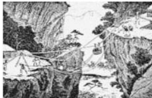
Dibujo en tinta china de un teleférico bicable empleado para transportar rocas para construir fortificaciones. Fuente: Artur Doppelmayr
