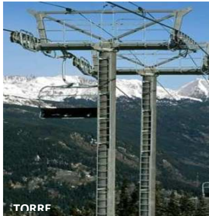
BALANCINES POLEAS DONDE SE DESLIZA EL CABLE
