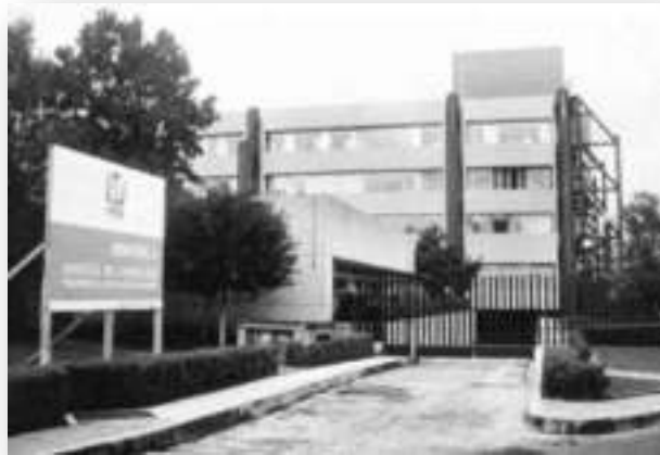
2. Hospital de Cardiología del Instituto Mexicano del Seguro Social que fue reforzado usando pórticos contrafuertes luego del sismo de México 1985.
