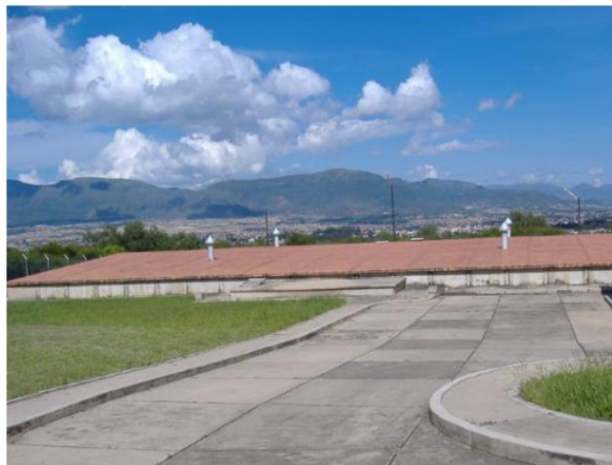
Figura 3-8 Tanque de Almacenamiento de Agua Potable
