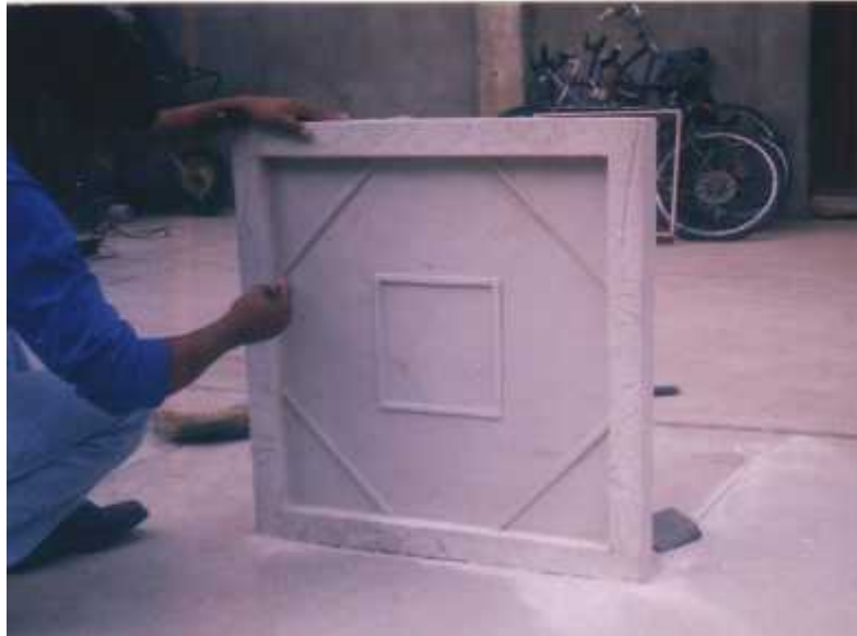
Fotografía N° 15 Afinado y limpieza del molde
