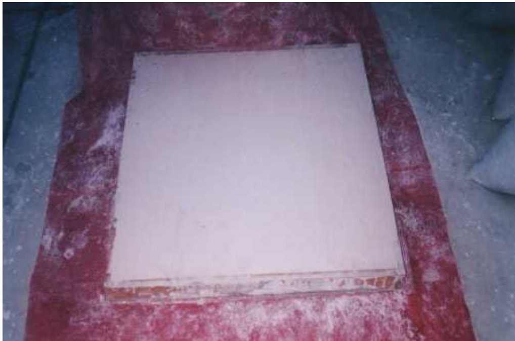
Fotografía N° 12 Culminación del vaciado de yeso cemento encima del positivo de arcilla.
