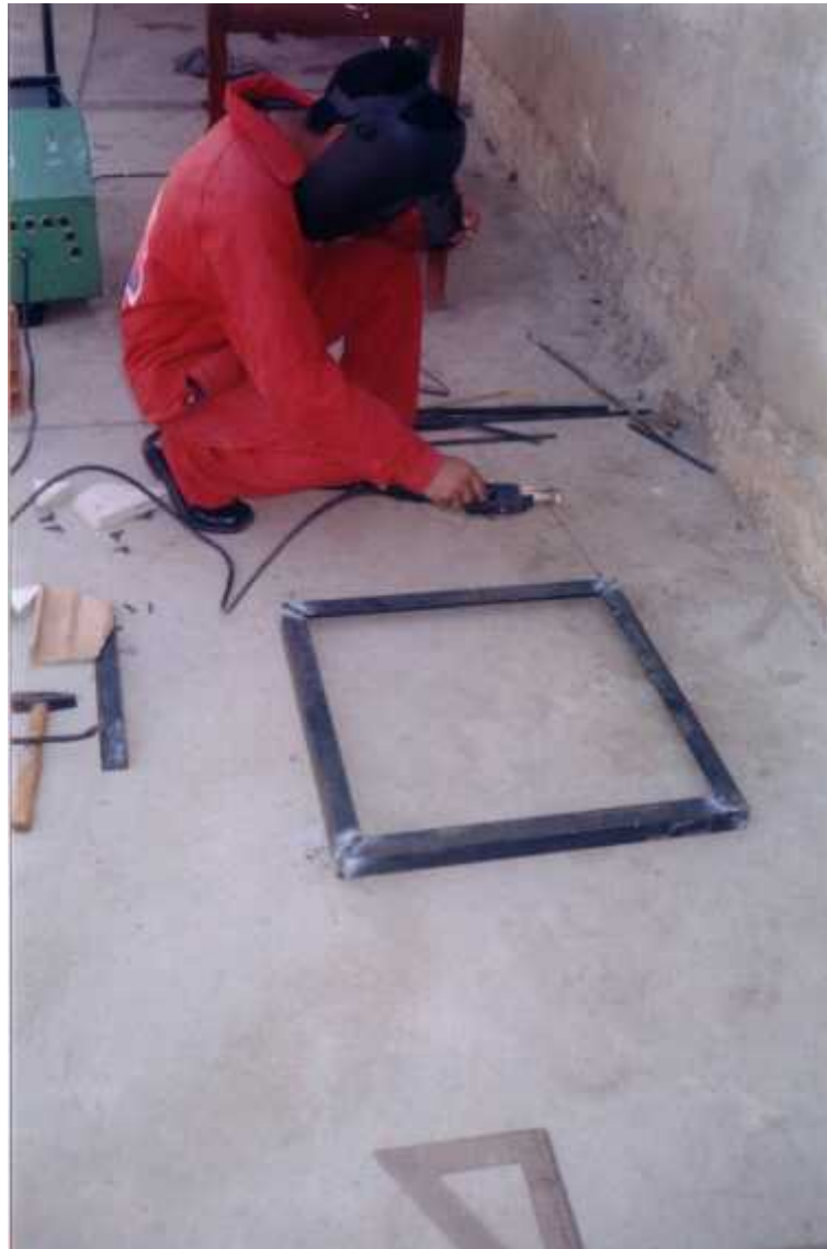
Fotografía N° 17 Molde en proceso de construcción
