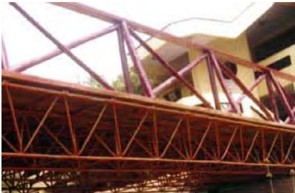
Figura 2.2 Fotografía Puente peatonal de la cantuta
