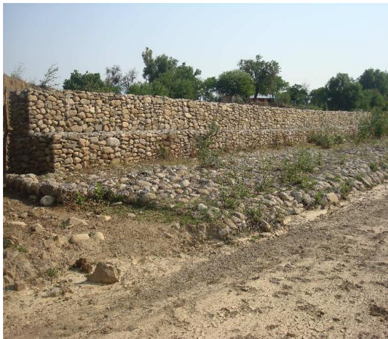
Figura 5.1: Gavión construido en la quebrada del Saladillo. Fuente: Elaboración propia.
