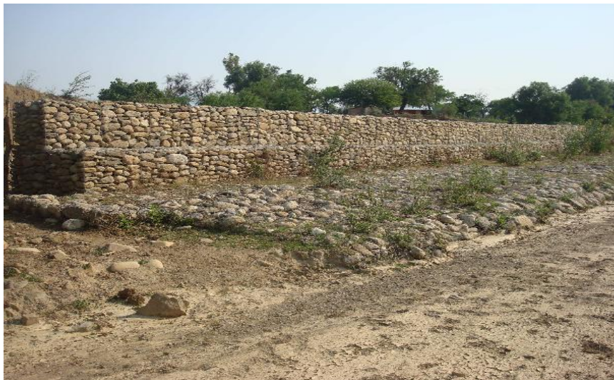
Figura 1.15: Gavión en buen estado. Fuente: Elaboración propia.
