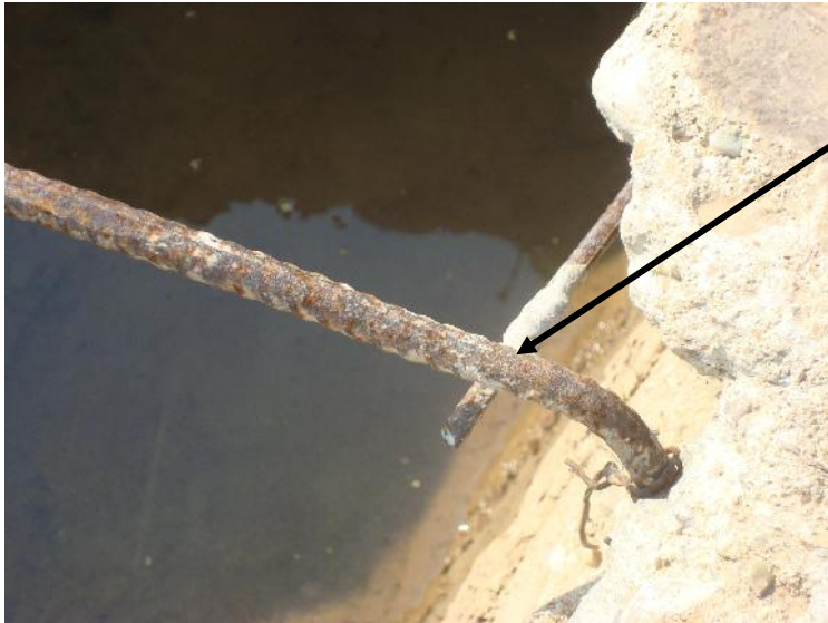
Figura 4.22: Tapa de cana colapsada. Fuente: Elaboración propia.
