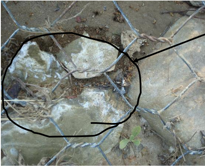
Figura 5.2: Inicio de corrosión del alambre de la malla del gavión debido a la presencia de sustancias corrosivas.
