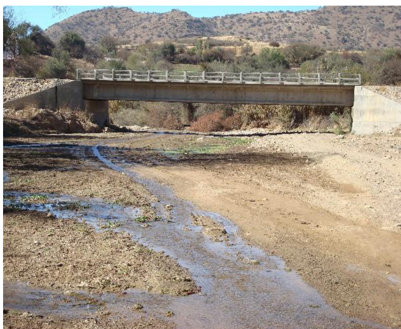
Figura 1.13: Puente de hormigón con vigas pretensadas construido el año 2006. Fuente: Elaboración propia.
