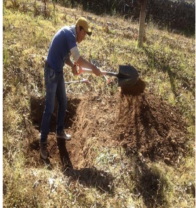
FOTOGRAFIAS N°5 Preparación del terreno para realizar las calicatas en cada sitio
