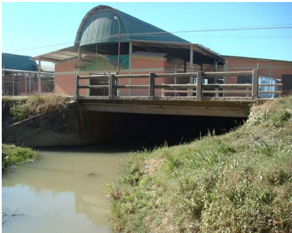
Fotografía N° 8 Condición del puente N° 1.
