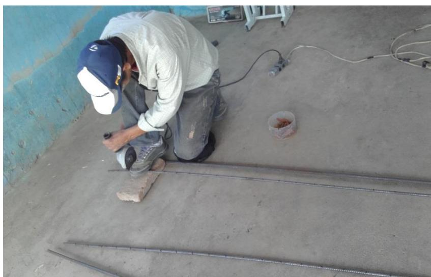
*Figura N° 8. Cortado del fierro corrugado*
