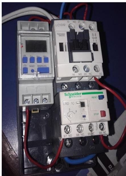
*Figura N° 21. Programador de riego automático*
