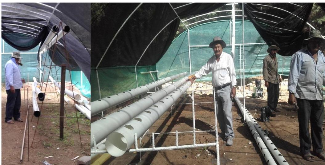
*Figura N°12. Trazado, alineación y replanteo de los caballetes*
