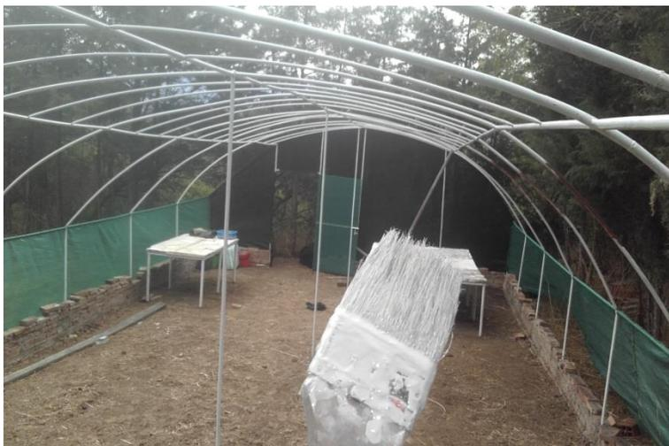
**Figura N° 2. Nivelado del área y pintado de las estructuras del invernadero**
