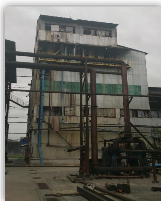
Figura 2.33. Destilería I.A.B.S.A. (Industrias Agrícolas de Bermejo Sociedad Anónima)
