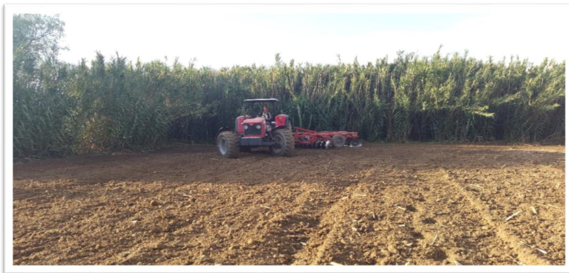
Foto 1.- Preparación del terreno
