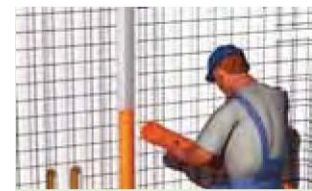
Colocado de tubo rígido
