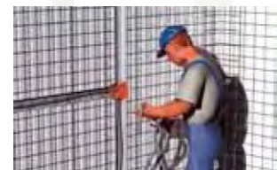
Colocado de tubo flexible
