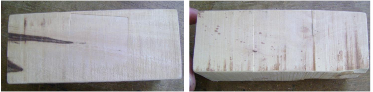
Foto 7: Penetración de la Placa Metálica
