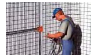
Colocado de tubo flexible
