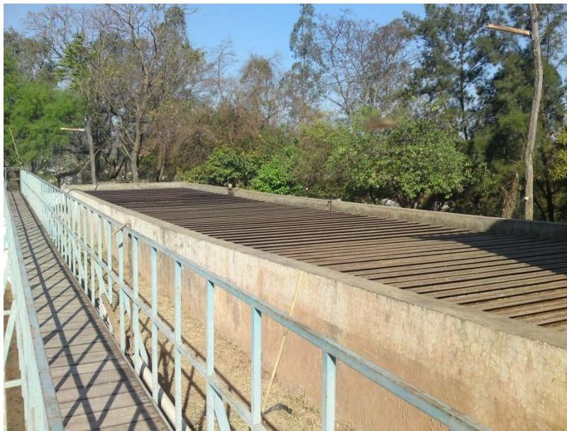
Figura I-9. Floculador Hidráulico
