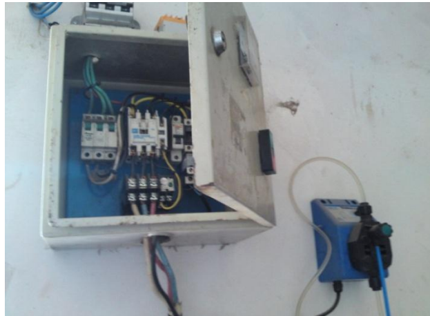
Figura V-4. Bomba dosificadora modelo F-MA
