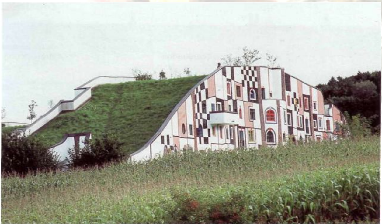
Hotel Rogner, Bad Blumau (Austria) (Arquitecto: F. Hundertwasser)
