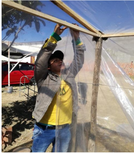
Instalación del plástico y vista del invernadero terminado
