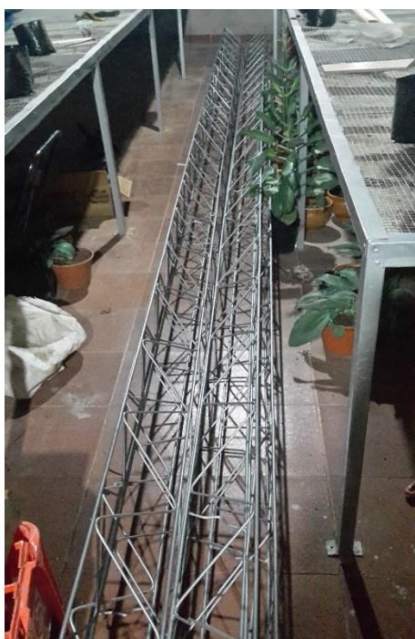
Estructura Metálica de los canales
