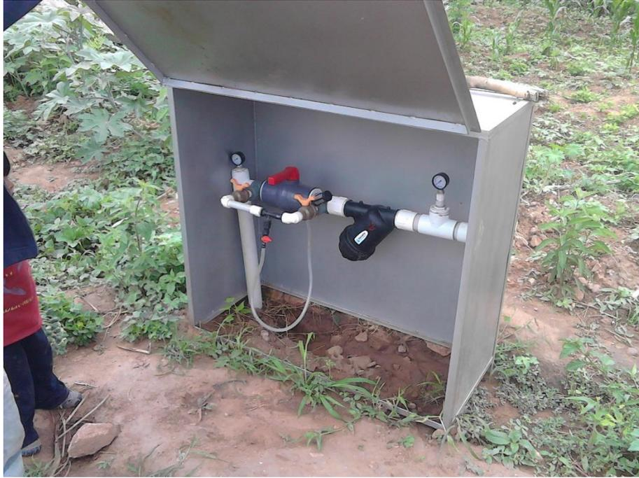
**Figura 11.** Cabezal del riego por goteo.
