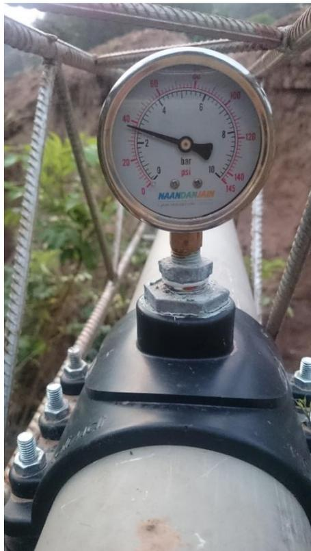
**Figura 10.** Manómetro en la matriz del sistema de riego que indica 2,6 bares de presión.
