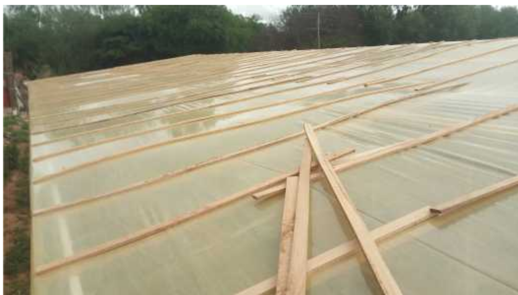
Figura: 3.11 instalación de agrofilm en el techo del invernadero tipo capilla.
