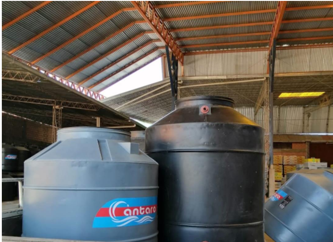
Imagen 3. Tanques de agua Cantaro
