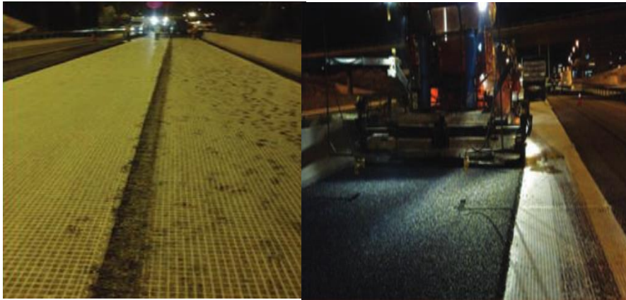
Figura 1.1: Método de empleo de la grilla de fibra de vidrio
