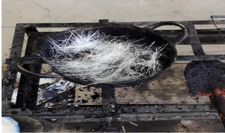
Figura N° 3.31. Incorporando fibra de vidrio a la mezcla asfáltica.
