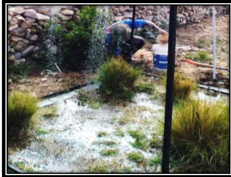
Figura 3.13 Cobertura pasto-paja Fuente: Elaboración propia
