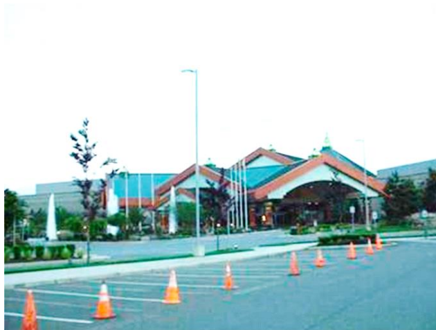
Figura 2.12. Parqueadero del casino Quil Ceda Creek, Estado de Washington.
