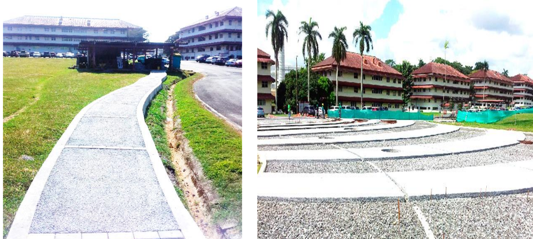
Figura 2.9. Aplicación de hormigón poroso en alamedas peatonales, en Panamá.
