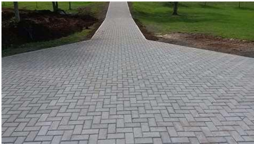
Figura 3 Superficie de rodadura.
