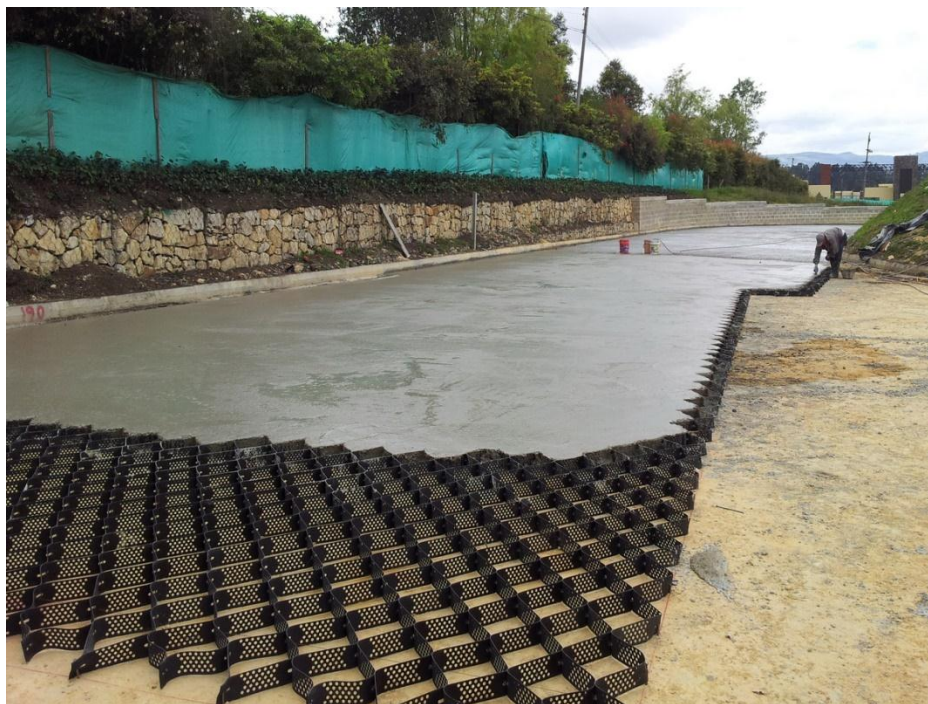
Figura 1 Pavimento construido con geoceldas como refuerzo.
