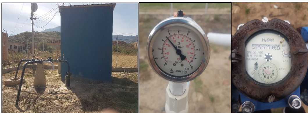
Figura 20. Estado actual del pozo Vela
