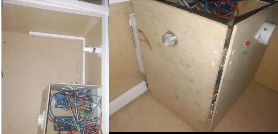
Imagen 61: Instalación de en el ambiente cocina
