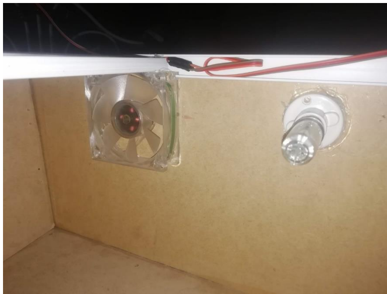
Imagen 62: Instalación de en el ambiente sala
