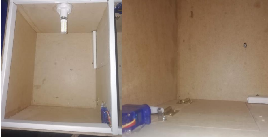
Imagen 60: Instalación de en el ambiente baño
