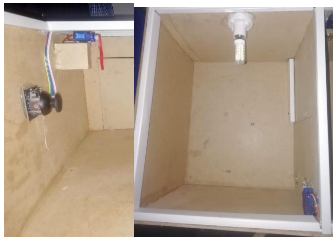
Imagen 59: Instalación de en el ambiente dormitorio
