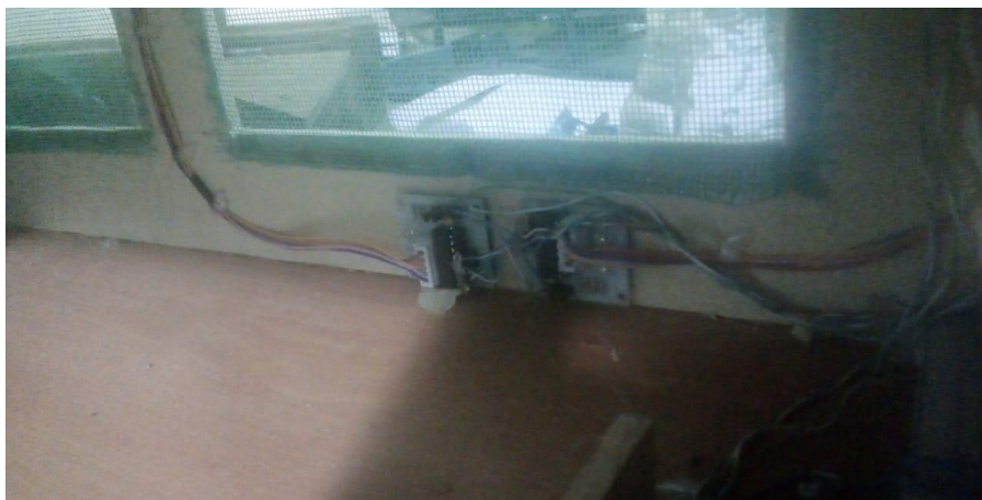
Ilustración 17: Construcción de prototipo
