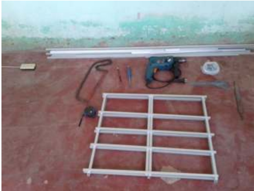
Figura 423: Herramientas utilizadas para la construcción
