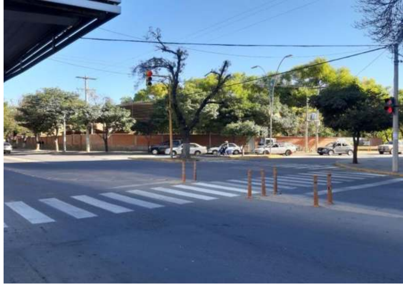
Figura II.29: Tachones ubicados en la avenida Integración intersección calle La Madrid, controlando movimientos vehiculares
