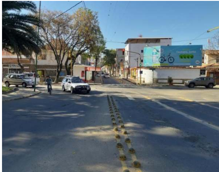
Figura II.30: Tachones ubicados en la avenida Víctor Paz Estensoro y calle Sucre-Acceso 4, controlando movimientos vehiculares
