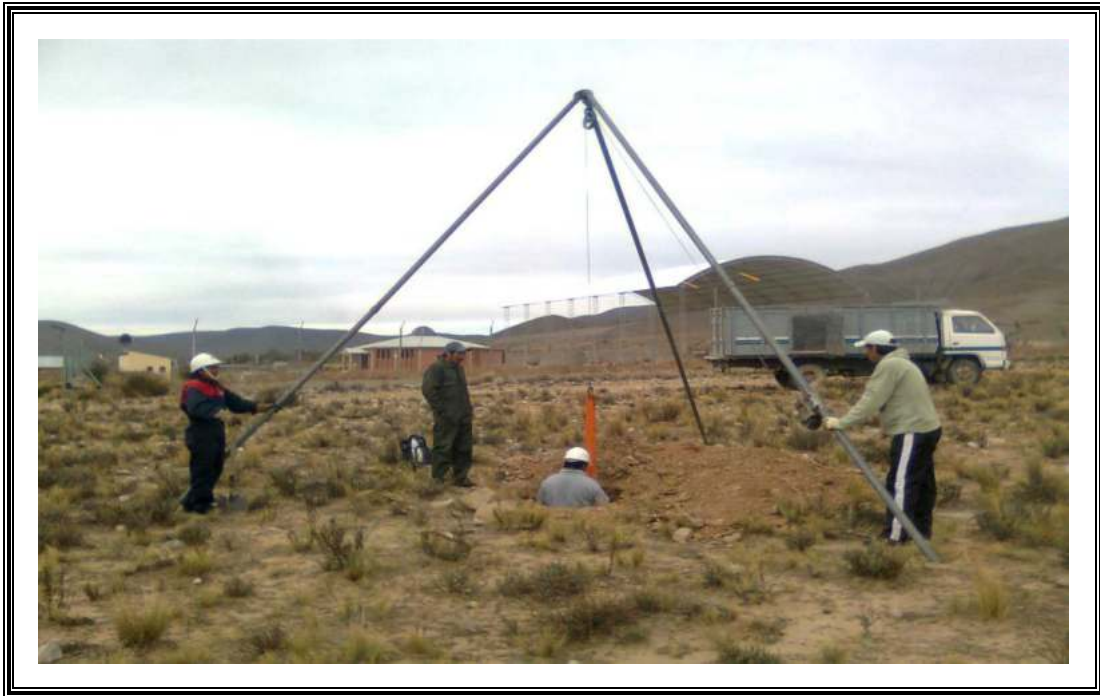
Imagen 3 Realizando el Estudio de suelos (Ensayo de S.P.T.)
