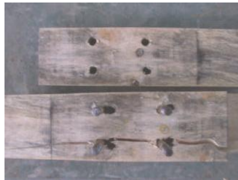
Fotografía N° 38. Desgarramiento de Muestra N° 5.
