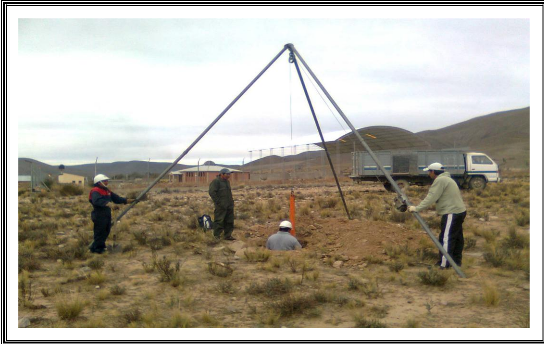
Imagen 3 Realizando el Estudio de suelos- Pozo N°1 (Ensayo de S.P.T.)
