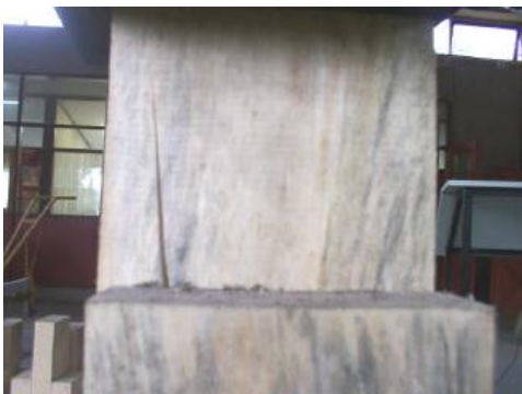
Fotografía N° 37. Desgarramiento de Muestra N° 5.
