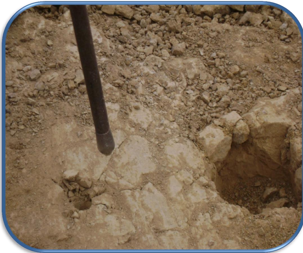
Figura66-PDC al lado del lugar donde se realizó Densidad in Situ 52
