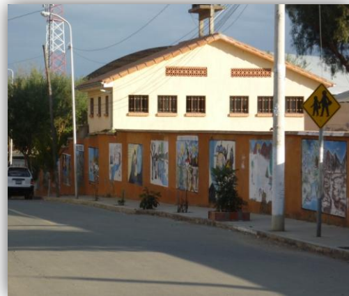
FIG.7 Vista lateral (Sur -Este)
