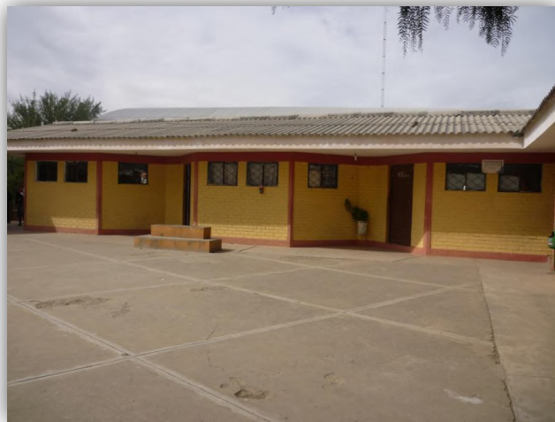
FOT. 4.-Vista de las aulas antiguas ubicadas en el sector este de la unidad educativa (modulo B) Elab. Propia
