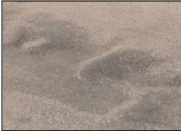
Figura (2-22). Hinchamiento en pavimento flexible.
