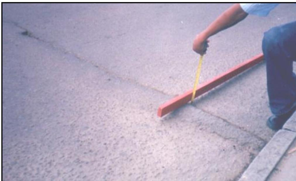
Figura (2-21). Elevación en pavimento flexible.
